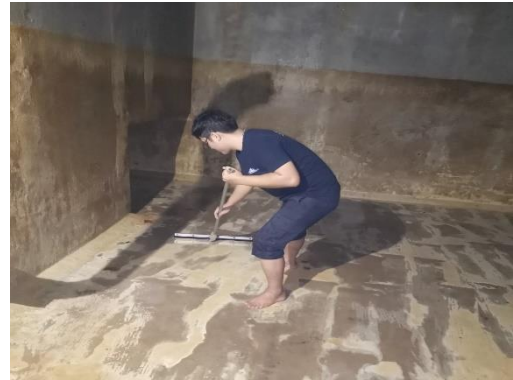
ล้างทำความสะอาดถึงสํารองน้ำ
