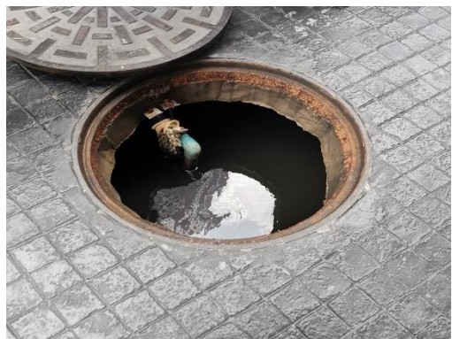
เจ้าหน้าที่ตรวจสอบปริมาณไขมันและตะกอน ภาพที่ 2.2-3 (ต่อ) ระบบบำบัดน้ำเสียและการบำรุงรักษา
