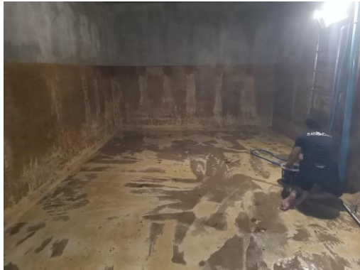
ล้างทำความสะอาดถึงสํารองน้ำ
