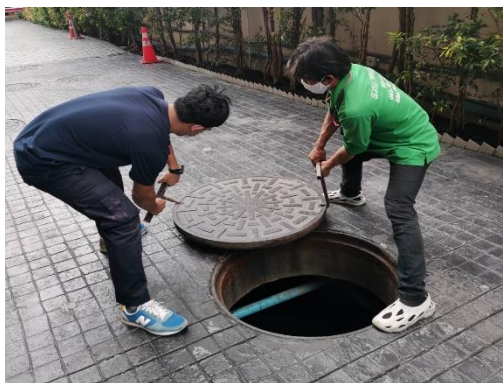
เจ้าหน้าที่ตรวจสอบปริมาณไขมันและตะกอน ภาพที่ 2.2-3 (ต่อ) ระบบบำบัดน้ำเสียและการบำรุงรักษา
